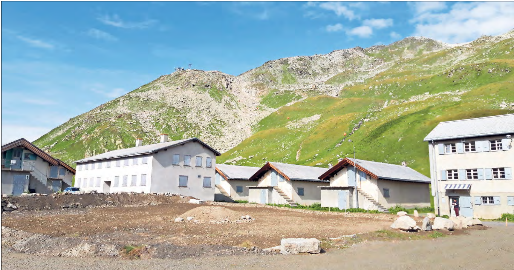
Das ehemalige Truppenlager der Armee auf der Furka mit der grossen Lücke im Vordergrund. Hier stand bis in diesem Sommer das sogenannte Kommandogebäude. Im Hintergrund schwach erkennbar die Bergstation der militärischen Seilbahn.
